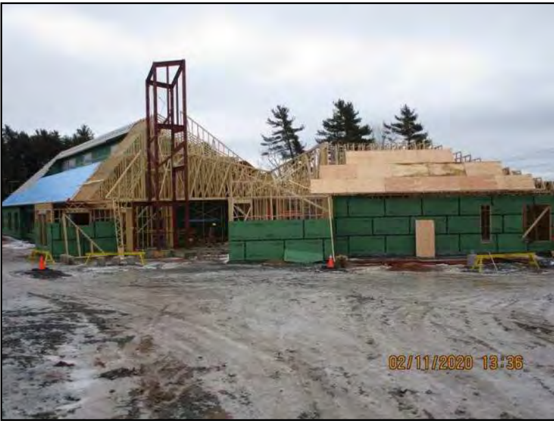
Pic 03 - NE corner
